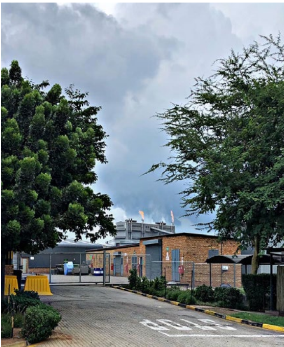
* Samancor TC Smelter blir platsen där PWR BLOK nummer 2 installeras.
